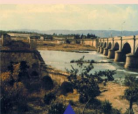
El río Guadalquivir a su paso por Córdoba
